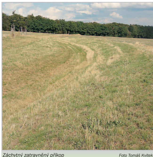
Záchytný zatravněný příkop
